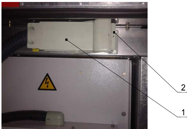
Рисунок 7 - Установка разъема выдвижного элемента.
