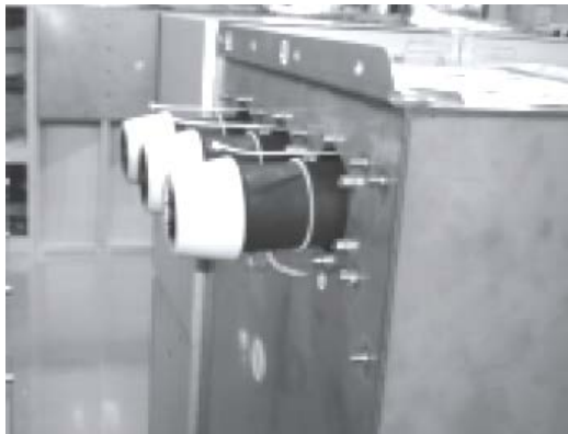
Рисунок 40 - Соединитель сборных шин
