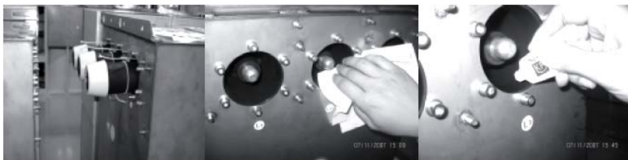
Рисунок 57 – Подготовка поверхности изоляторов с шинным контактом
