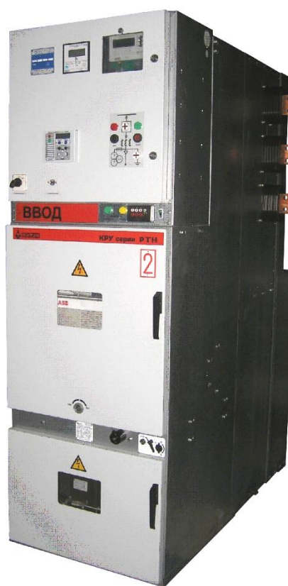
КРУ двухстороннего обслуживания
