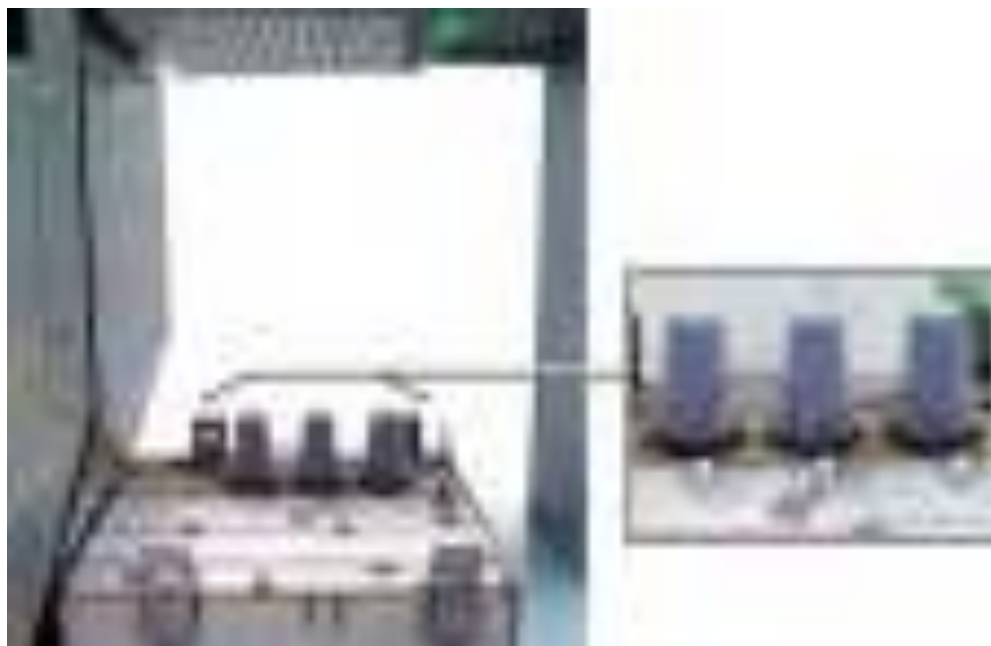
Рисунок 37 - Расположение фаз проходных изоляторов в шинном отсеке
