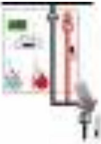
Снять навесной замок (рычаг запирающего механизма сам пойдет вниз)
