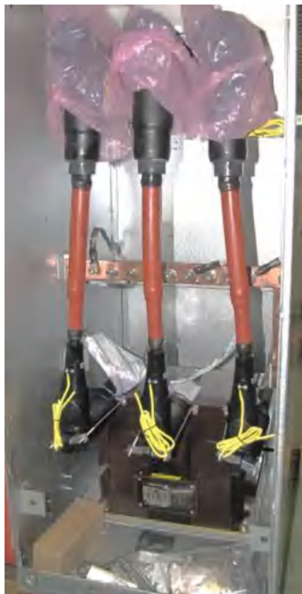
Внешний вид трансформаторов напряжения
