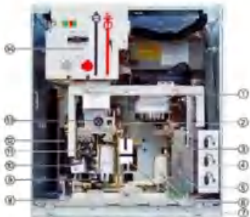
Рисунок 1 - Привод силового выключателя
