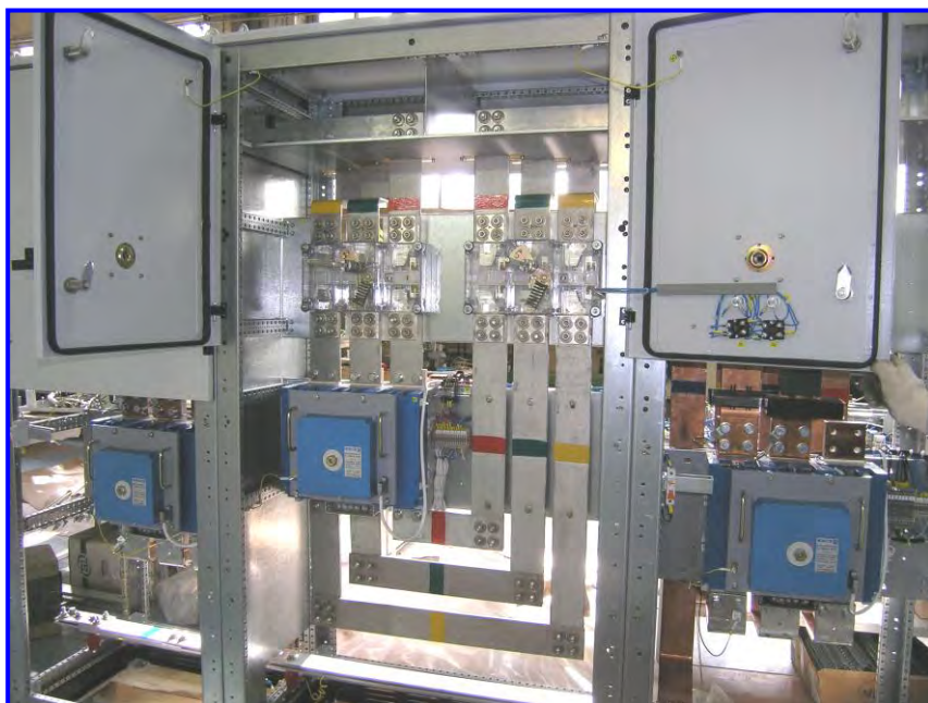
Секционная панель НКУ (защитный кожух не показан)
