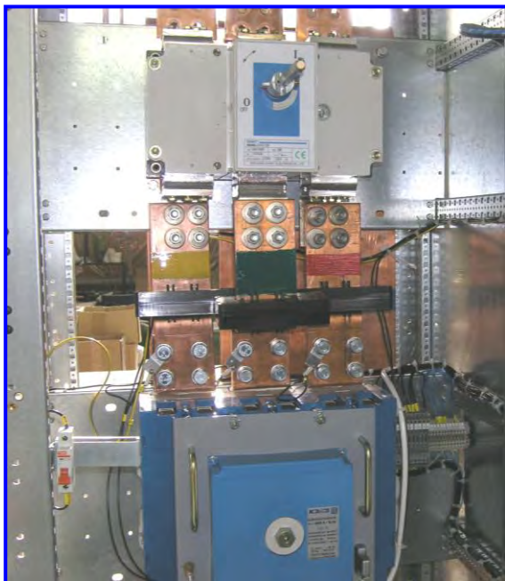
Секционная панель НКУ (защитный кожух не показан)
